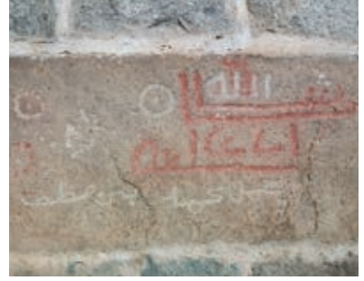
Polatoğlu Konağı'nda Osmanlıca tarih ve yazılarla birlikte kullanılan daire içinde noktadan oluşan Ant Damgası, Şenköy (Amokta) köyü
